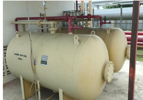
ระบบโฟมดับเพลิง (Fixed Foam System) จำนวน 7,530 ลิตร
